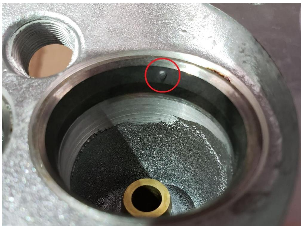
Imagem 3 – Identificação da marca original do fabricante no ângulo de correção inferior da sede.
